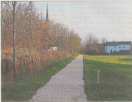
Ein neuer Gehweg entlang des Mühlbaches entstand in der Pechler Au.
